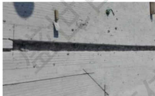
3.地基开槽 宽高均匀
