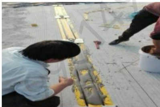
6.安装窄条、胶水固化 平整度
