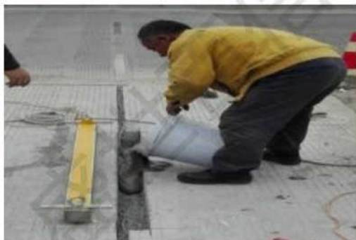
5.布线灌胶 导线防护、胶水固化
