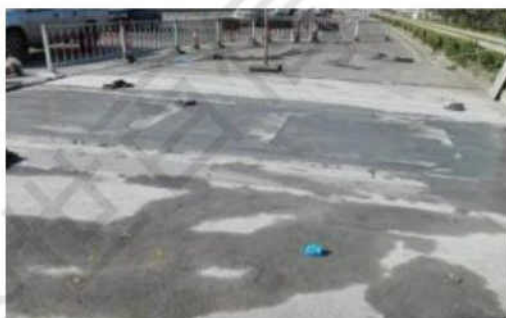
1.地基浇筑 确保1%水平度、强度
